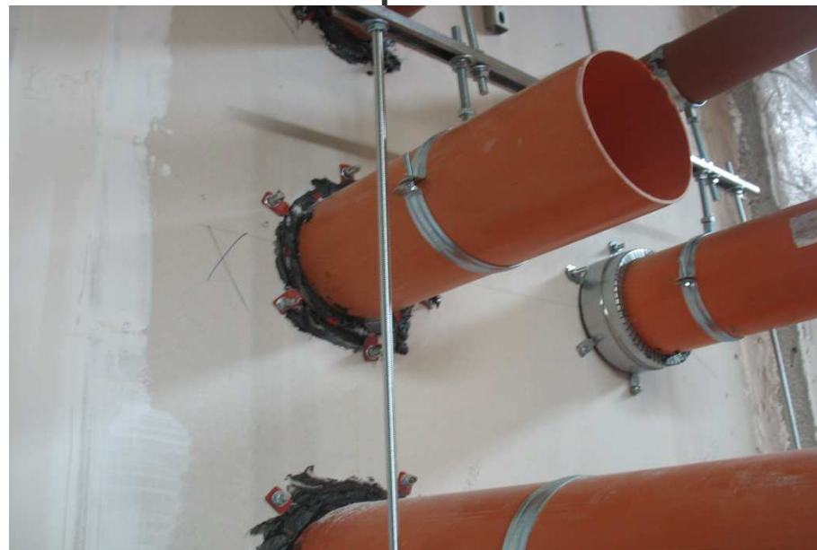
Collari intumescenti per tubazioni combustibili
