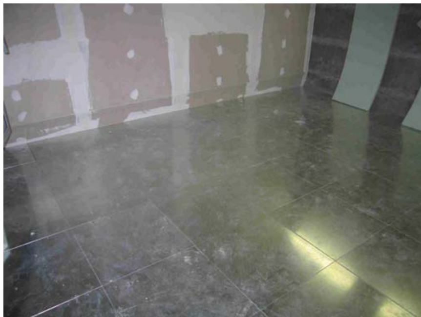
Foto 2. Pavimento tecnico sottoposto a prova secondo la norma UNI EN ISO 140-12:2001
